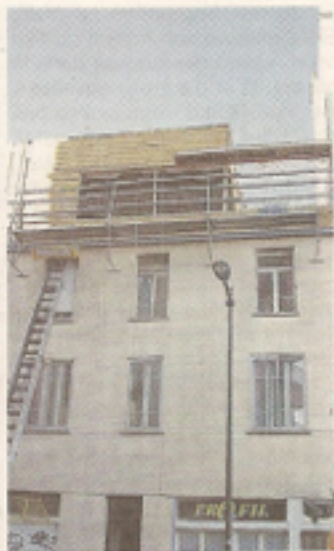
Le chantier a démarré à la mi-juillet. Il s'est interrompu en août et vient de reprendre.
